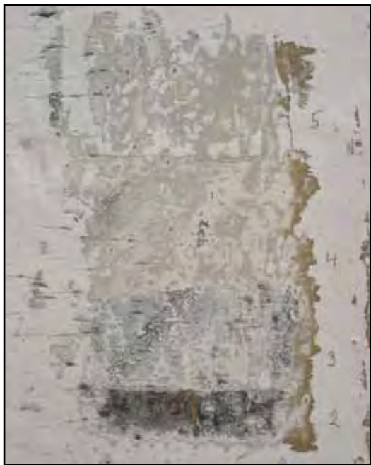
Färgtrappa på pilaster. Nr 3 är en påtagligt grå kulör med kraftfull mörk marmorering. Det är oklart om nr 2 skall tolkas som helt svart.
