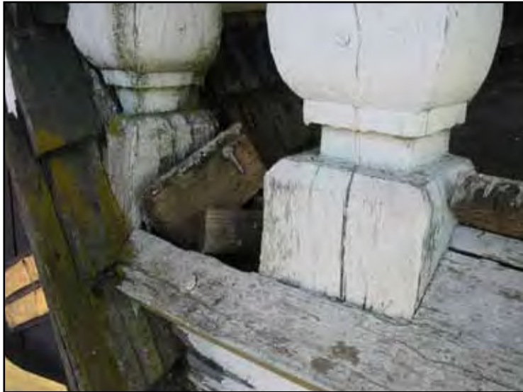
Exempel på skador på balustraden. Ovan på västra sidan. Till höger den östligaste av balusterdockorna på norra sidan där kärnan är rötskadad.
