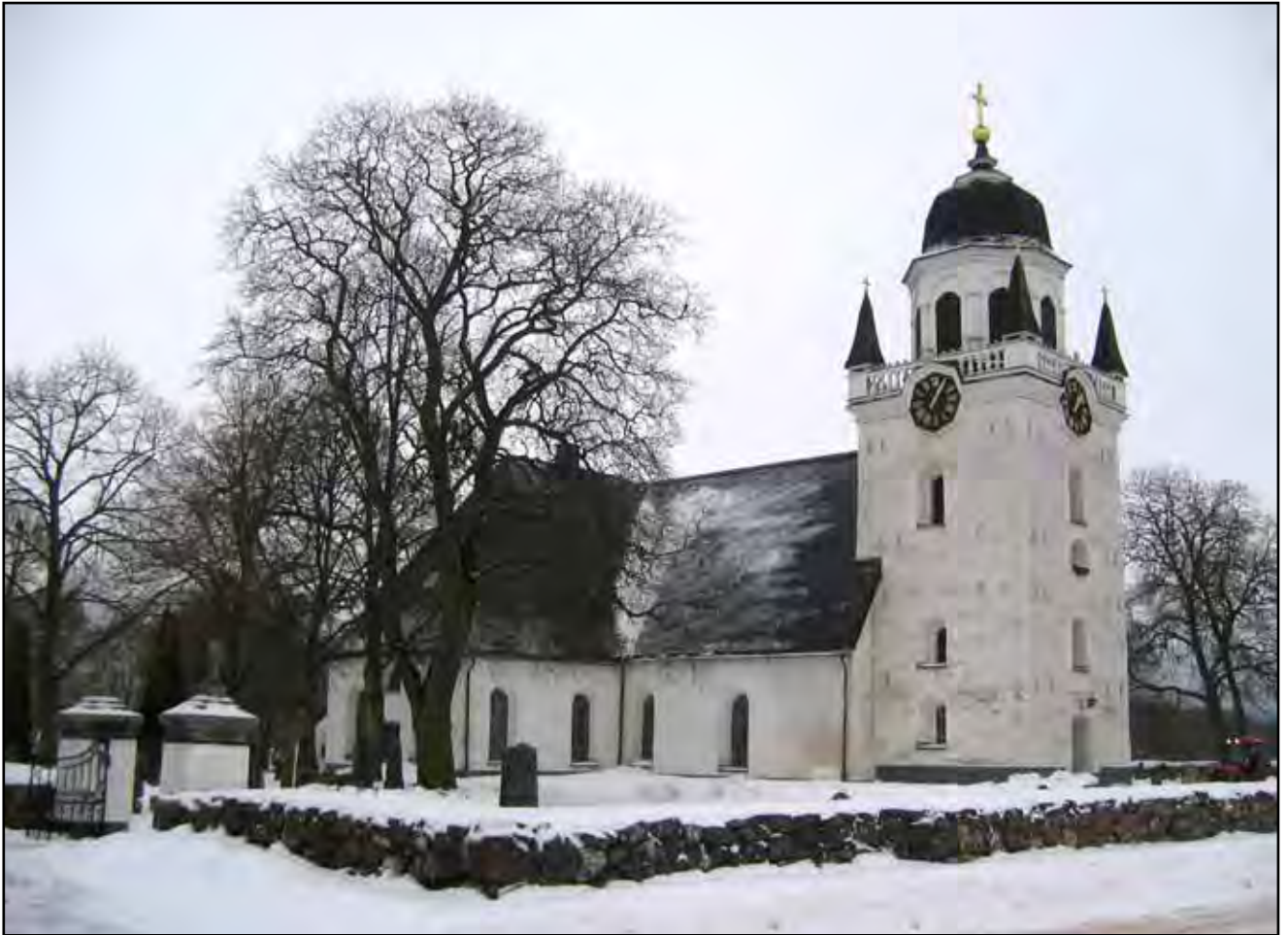
Säby kyrka fotograferad från nordväst år 2006. Fasaderna bär en obruten vit kalkavfärgning med partiell påväxt av alger. Tornlanterninen är målad i en slät vit oljefärg, en svag marmorering av pilastrarna är osynlig från mark. Socklarna är målade med en mörkgrå plastfärg. Fotograf: Jonas Haas.
