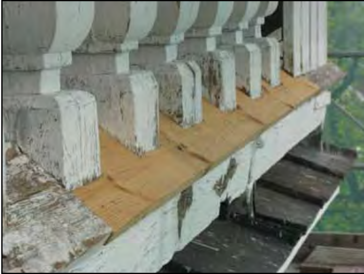
Nytt stycke lockbräda på balustradens underliggare åt öster, fäst med gammal och ny smidd spik.
