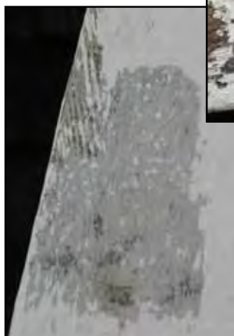
Till vänster färgtrappa på fält kring luckor. underst spår av röd slamfärg. Ovan till vänster grå marmorering på grå botten på balusterdocka, troligen från 1834. Ovan till höger en närmast svart marmorering på mörkgrå botten (kimrök?) på det nedre av spirans två listverk, den ursprungliga?
