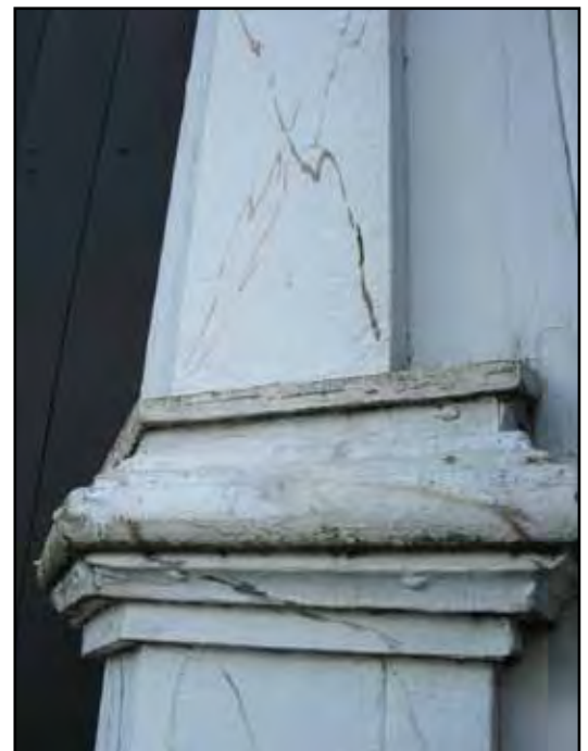
Lanterninens pilastrar är målade i obrutet vitt med en diskret marmorering som ej syns från mark.
