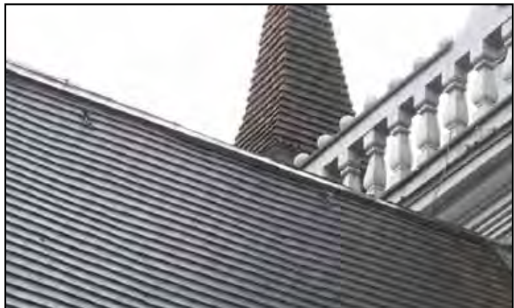
Fästöglor för säkrare arbetsmiljö vid tjärning, monterade undernock på långhusets norra takfall.
