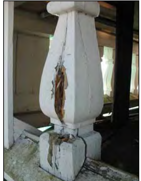
Exempel på skador på balustraden. Ovan på västra sidan. Till höger den östligaste av balusterdockorna på norra sidan där kärnan är rötskadad.
