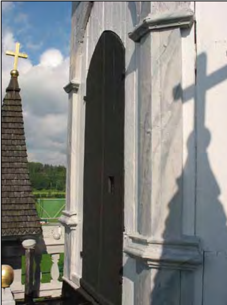
Detalj av lanterninen med den nya marmoreringen som grundar sig på de spår som kunde iakttas.
