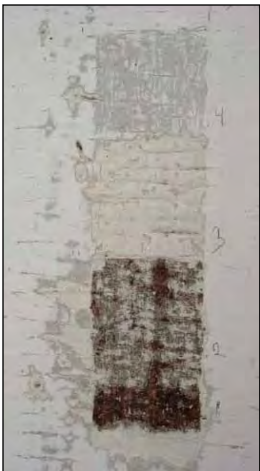
Färgtrappa på pilaster. Nr 3 är en påtagligt grå kulör med kraftfull mörk marmorering. Det är oklart om nr 2 skall tolkas som helt svart.
