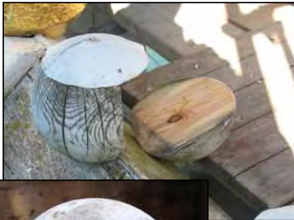
Exempel på skador på balustraden. Ovan på västra sidan. Till höger den östligaste av balusterdockorna på norra sidan där kärnan är rötskadad.
