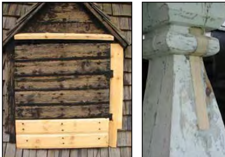
Till vänster: Lanterninhuvens lucka åt öster har kompletterats med ny dropplist, foderbräda och två panelbrädor är utbytta, allt är fäst med smidd spik. Till höger: Ilusning på en av balusterdockorna åt norr.
