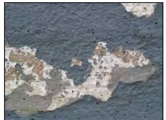
På sockeln sitter ytterst en mörkgrå plastfärg, därunder en silikatfärg i grön umbra och underst en vit kalkfärg.
