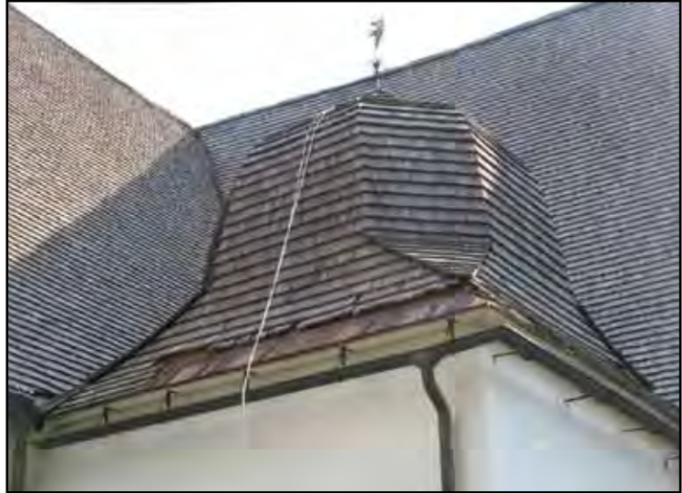
Lagning av undertak och spånbyte på västra takfoten på Wittingska gravkoret.
