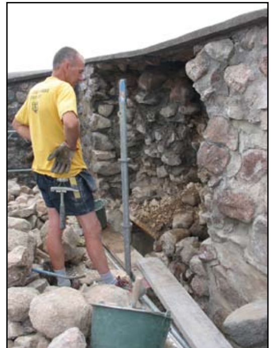
Inre skalmuren och den nästintill obefintliga murkärnan nedtagna över porten och återuppmurnning påbörjad. Endast skalmuren på utsidan var i god kondition. Roland Pettersson i bild.
