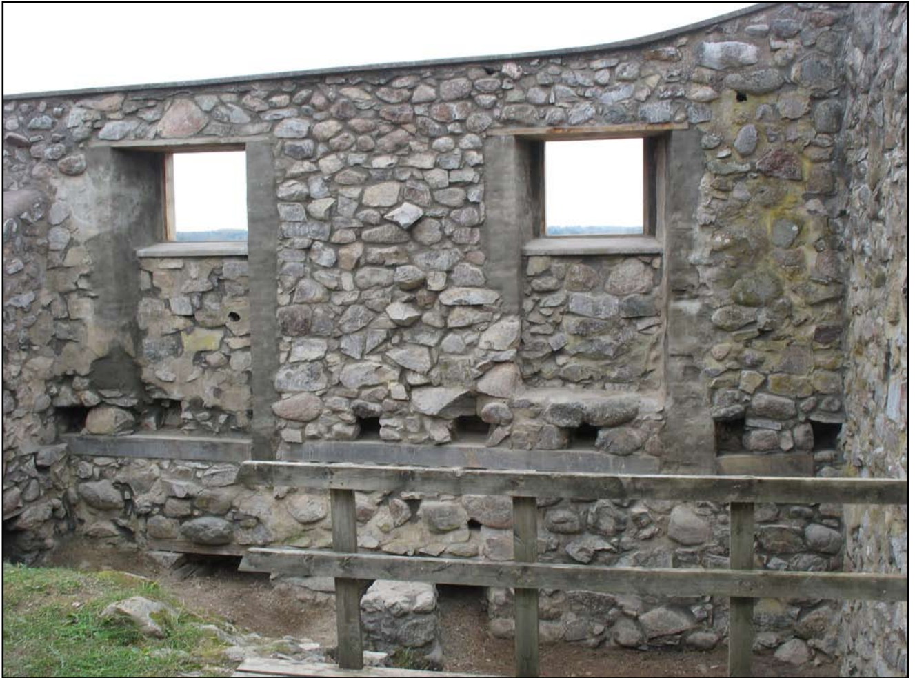
Den östra murens insida efter restaurering. Partiet mellan fönstren i bild är nästan helt ommurat från samma nivå som högra fönstermsygens botten. Även över fönstren är murverket ommurat från insidan och nya ekplank inlagda. Tegelomfattningarna har lagats och slammats. I öppningen efter det försvunna bjälklaget har stabiliserande ekbjälkar monterats.
