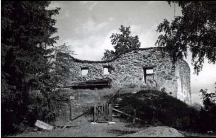
Brahälla efter den första restaureringen, fotograferad 1935 av Claes Claesson. Murkrönen är enbart avtäckta med grästorv. JLM.
