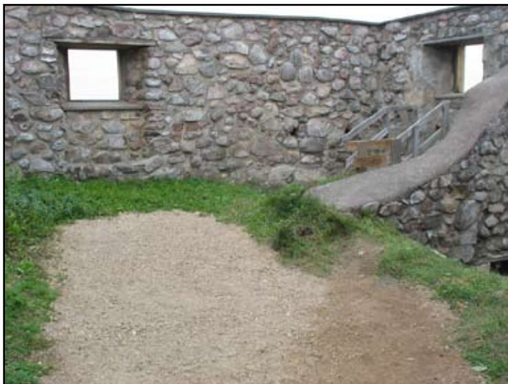
Ruinens inre mot norr efter restaurering. En svacka i marken är utfylld med finfördelat äldre bruk.
