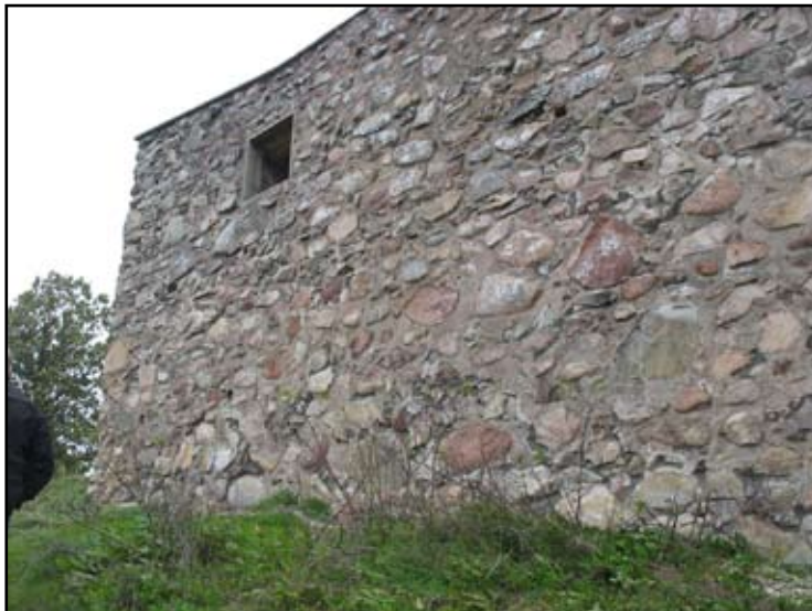
Södra murens utsida efter restaurering.
