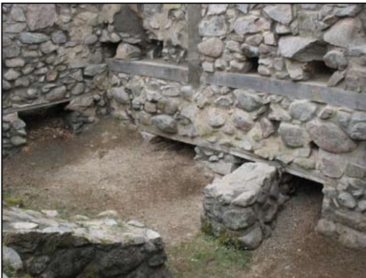
Ovan: källaren har efter rensning blivit mer lättavläst. T.h: sista delen av återuppmurningen av murpartiet mellan de båda fönstren i öster.
