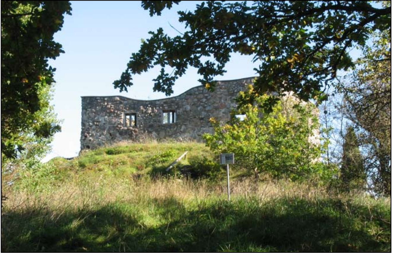
Brahälla slottsruin fotograferad 2008. Observera att fönsteröppningarna stöttats upp med plank för att förebygga ras.
