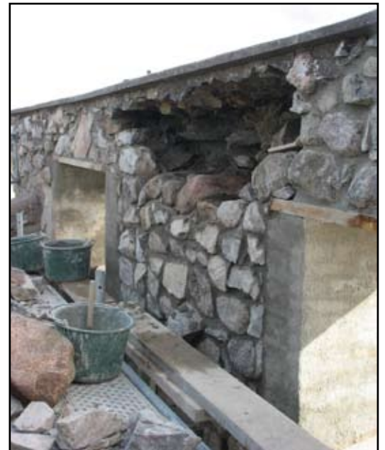
Den östra murens insida efter restaurering. Partiet mellan fönstren i bild är nästan helt ommurat från samma nivå som högra fönstermsygens botten. Även över fönstren är murverket ommurat från insidan och nya ekplank inlagda. Tegelomfattningarna har lagats och slammats. I öppningen efter det försvunna bjälklaget har stabiliserande ekbjälkar monterats.
