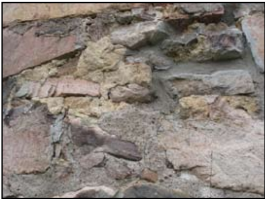
Ett av få murpartier med bevarade originalfogar finns nära sydvästra hörnet.
