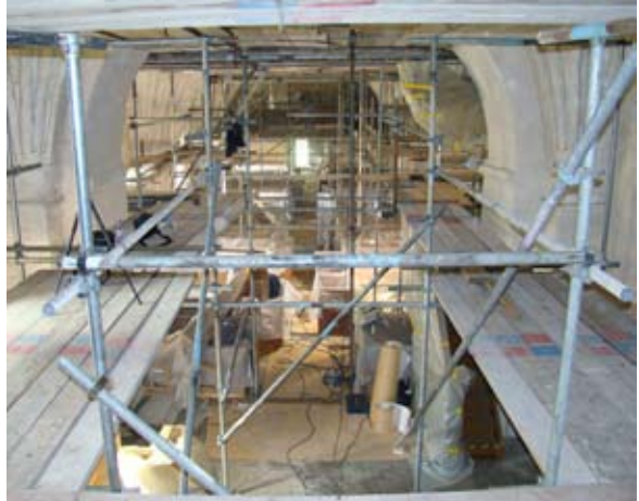
Ovan: Exteriör av Moheda kyrka samt interiörbild med byggnadsställningar.
